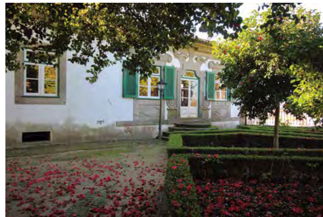
Fig. 216 O Solar dos Condes de Resende, em Vila Nova de Gaia.
