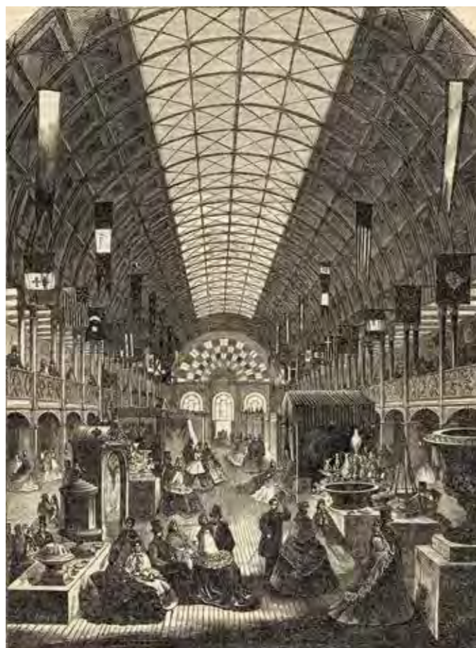
Fig. 52 Interior da nave central do Palácio de Cristal durante a Exposição Internacional do Porto.
